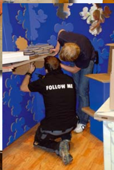
En hel del muttrande och skruvande blir det under monterarbetet.
